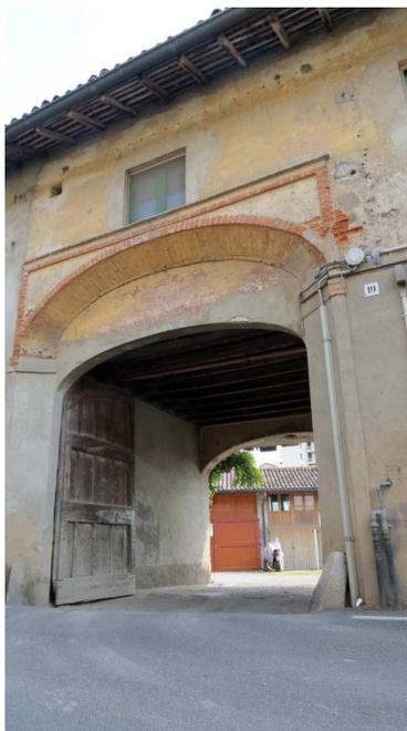
Fig. 7. *La modifica della volta dell'arco di ingresso alla corte è ancora perfettamente visibile*
