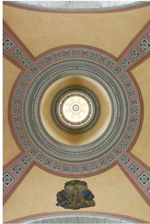
Fig. 11. Vista complessiva della cupola
